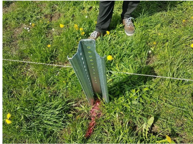
Abbildung 10: Rammfundament
