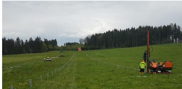
Abbildung 7: Hydraulikramme auf Ketten
