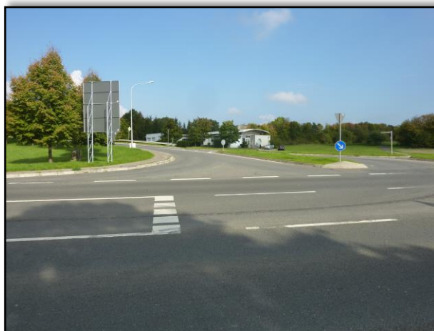
Bild 14: Netzknotenpunktes NK 6422 014 (Knotenpunkt Seitenarm Bundesstraße B27 / Kreisstraße K3910) – Blick in Richtung Nordwesten.
