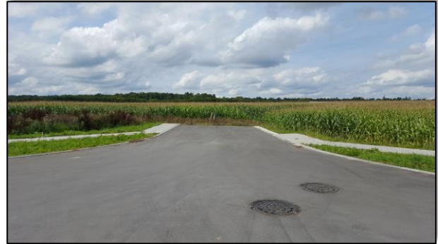
Bild 10: „Industrieparkstraße“ Planbereich „ZG Raiffeisen / VIP III“ - Gepl. Straßenanbindung „Am Limes“ in Richtung Norden
